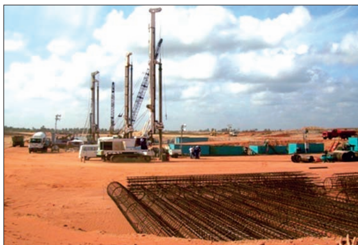
■ [Foto 1].- Vista de la obra.
